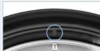
圧力パッキンに表示されたパッキン組立用基準表示の突起
